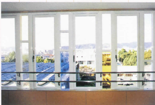
全面改修された4Fトイレの窓から見える景色です。
